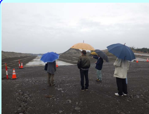
➤ 中田島砂丘で施工中の防潮堤を見学
