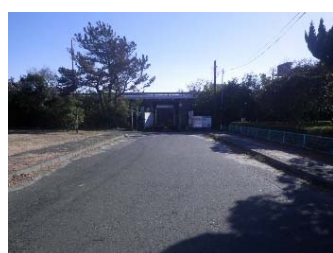
舞阪6号地下道
