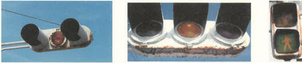
図 4 「老朽化が進む信号灯器」
