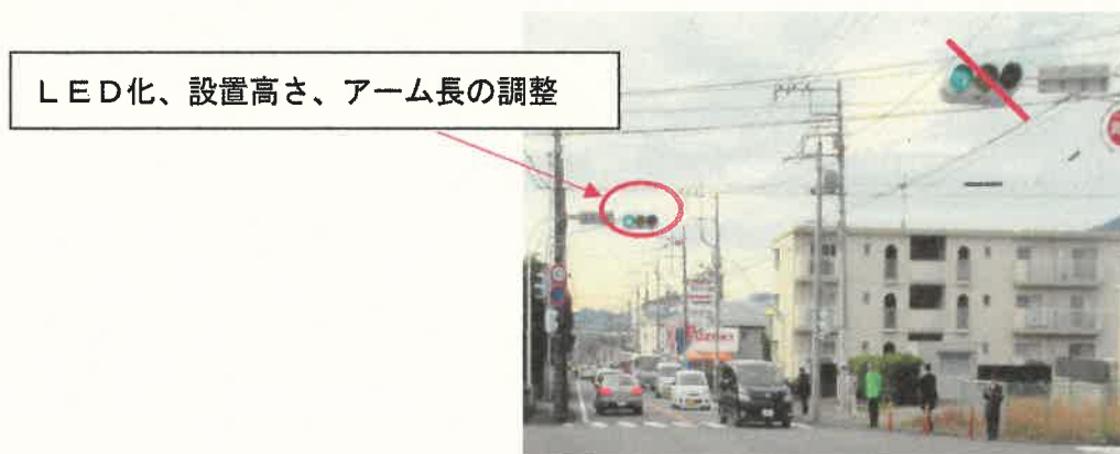
図 14 「不要な信号灯器の撤去 (イメージ)」
