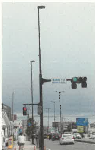
図 13 「統合柱による信号機の設置（例）」
